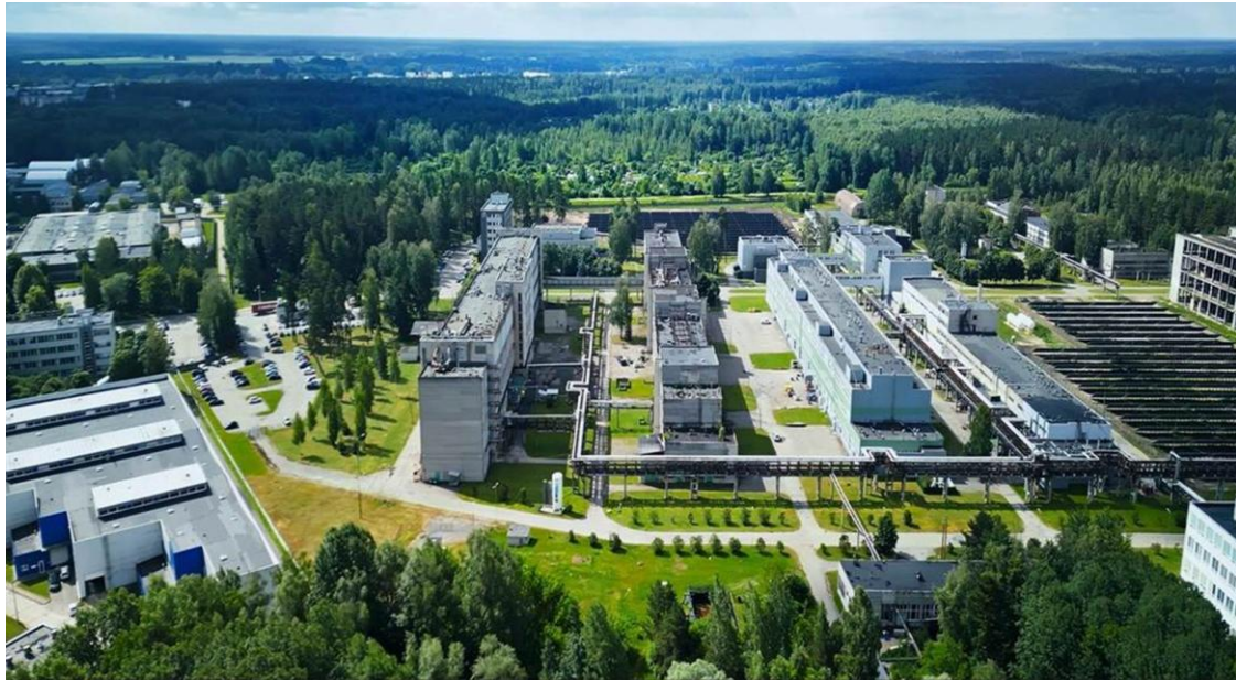
日鼎水務 桃園北區水資中心廠區
