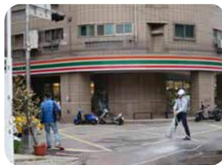
工地現場周遭環境維護
